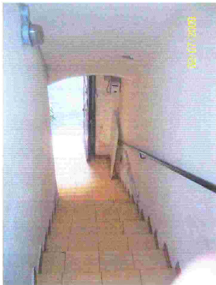
Foto n°5 - Veduta del vano scala di accesso al primo piano.
