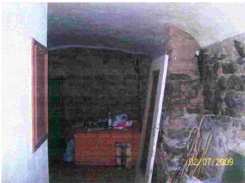
Foto n°4 - Veduta del locale ubicato al piano terreno.
